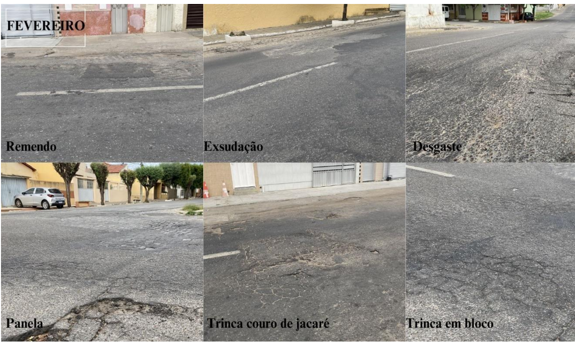
Figura 7 - Defeitos com alta e média frequência na rua Dom Pedro II no mês de fevereiro
