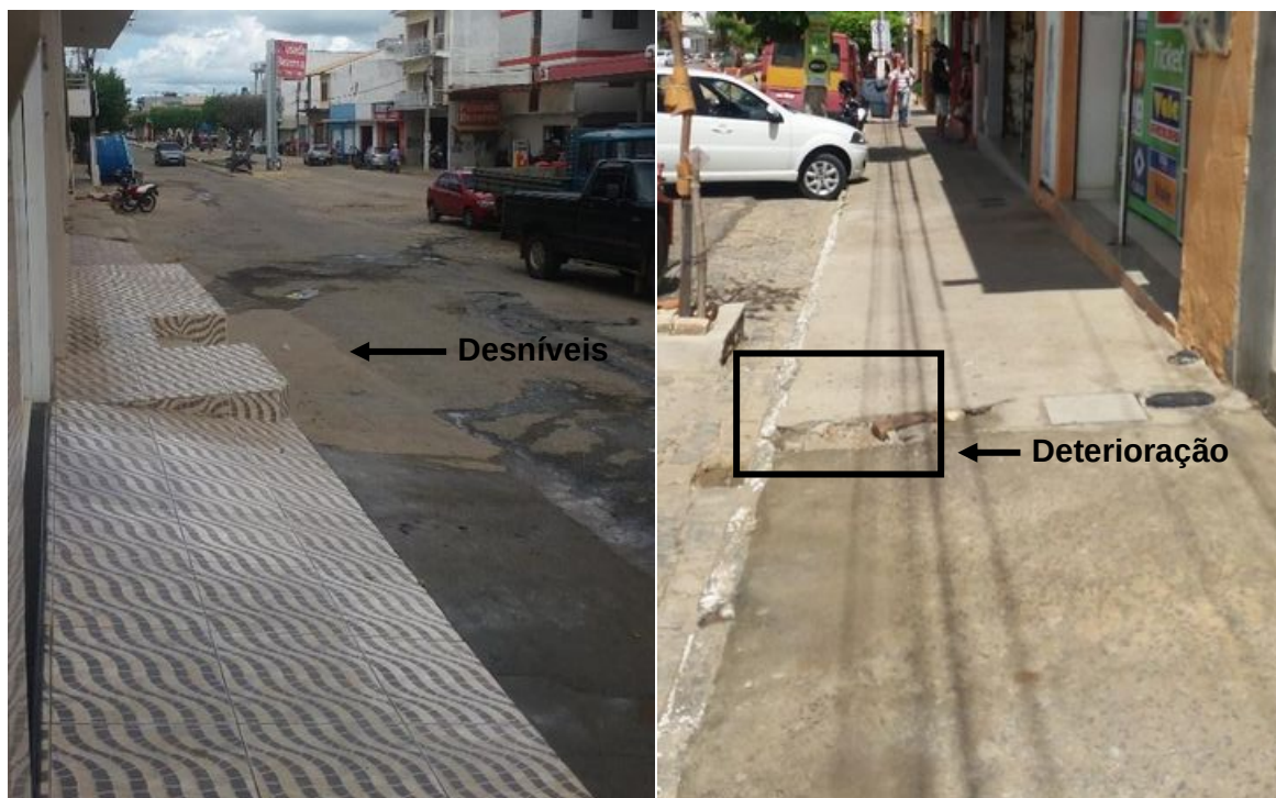
Figura 58: Calçada das vias principais com desníveis e deterioração.
