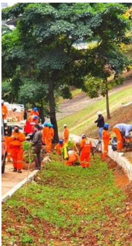
Figura 15: Execução da biovaleta na Av. 13 de Maio, em São Paulo.
