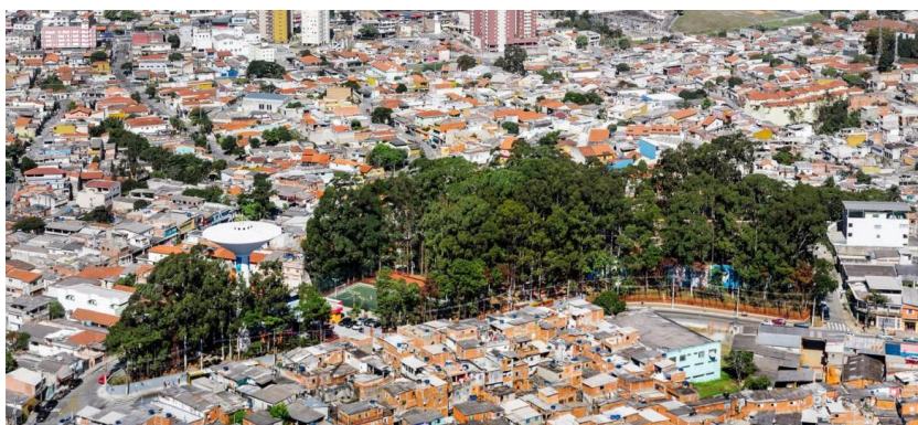
Figura 39: Vista aérea do Parque Cangaíba.
