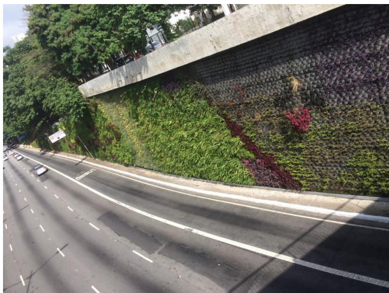
Figura 14: Corredor Verde da Avenida 13 de Maio, em São Paulo.
