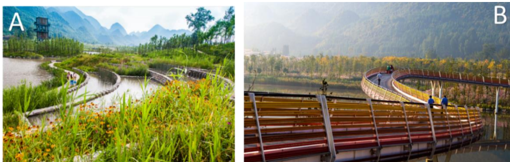
Figura 25: Biovaletas construídas no parque (A) e Ponte Arco-íris (B).
