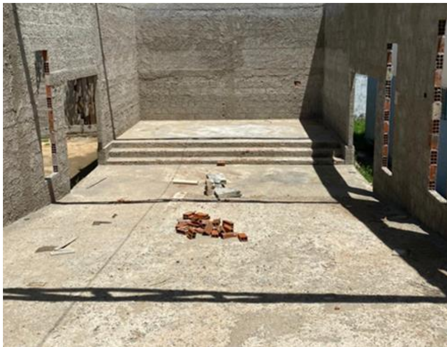
Figura 16 - Revestimento de piso
