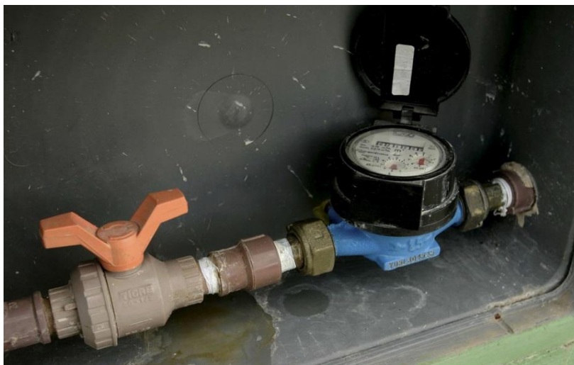
Figura 12 - Hidrômetro da Obra
