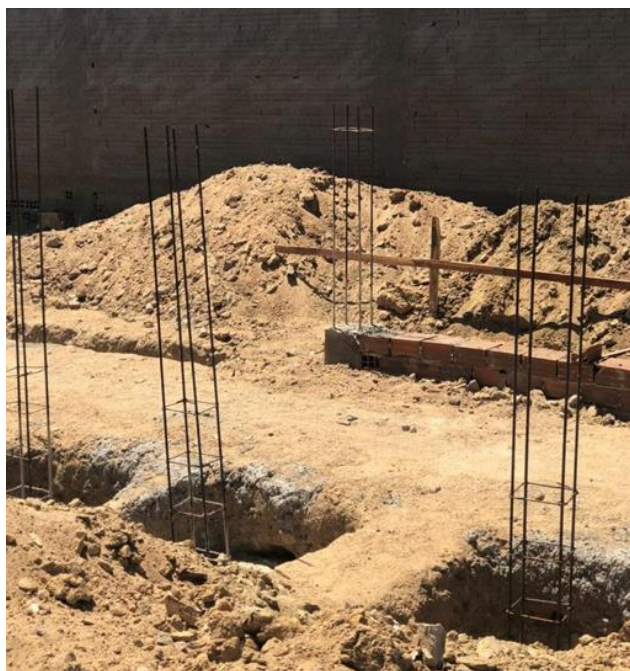
Figura 14 - Concretagem da Fundação
