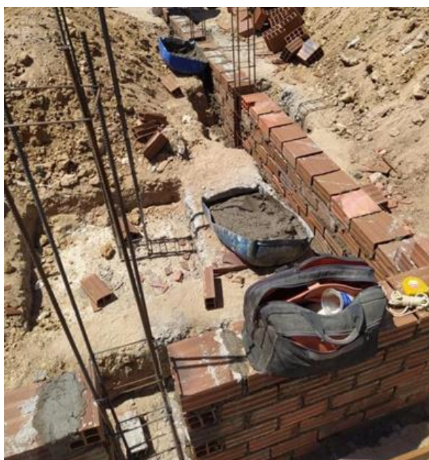
Figura 15 - Concretagem das Vigas Baldrame
