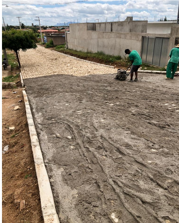
Figura 5: Pavimentação pelo método convencional
