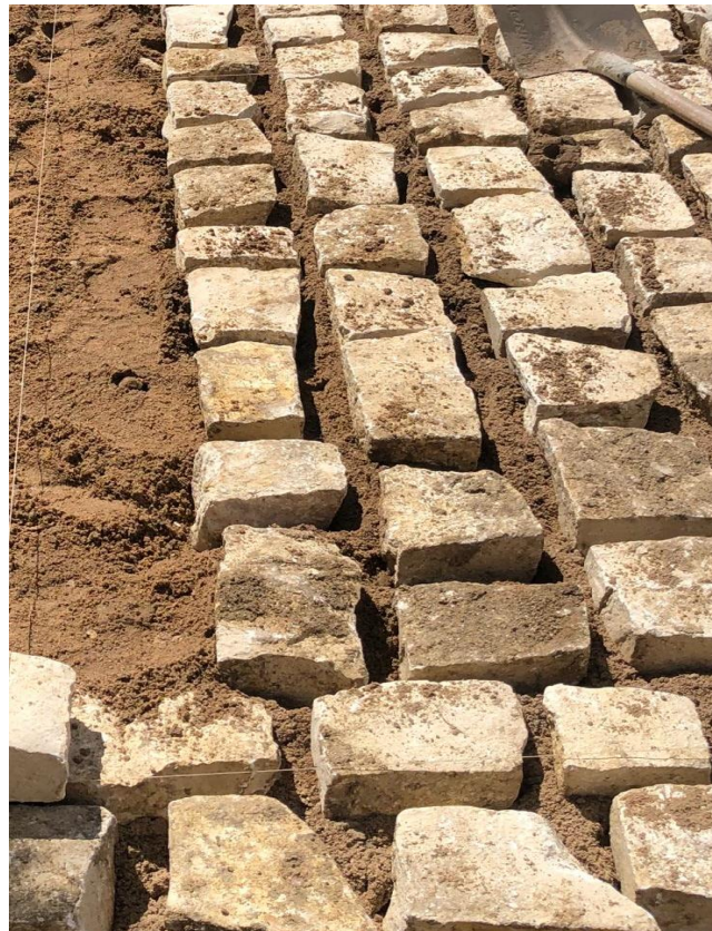
Figura 11: Espaçamento entre as juntas longitudinais e transversais de pavimentação com pedra calcária.
